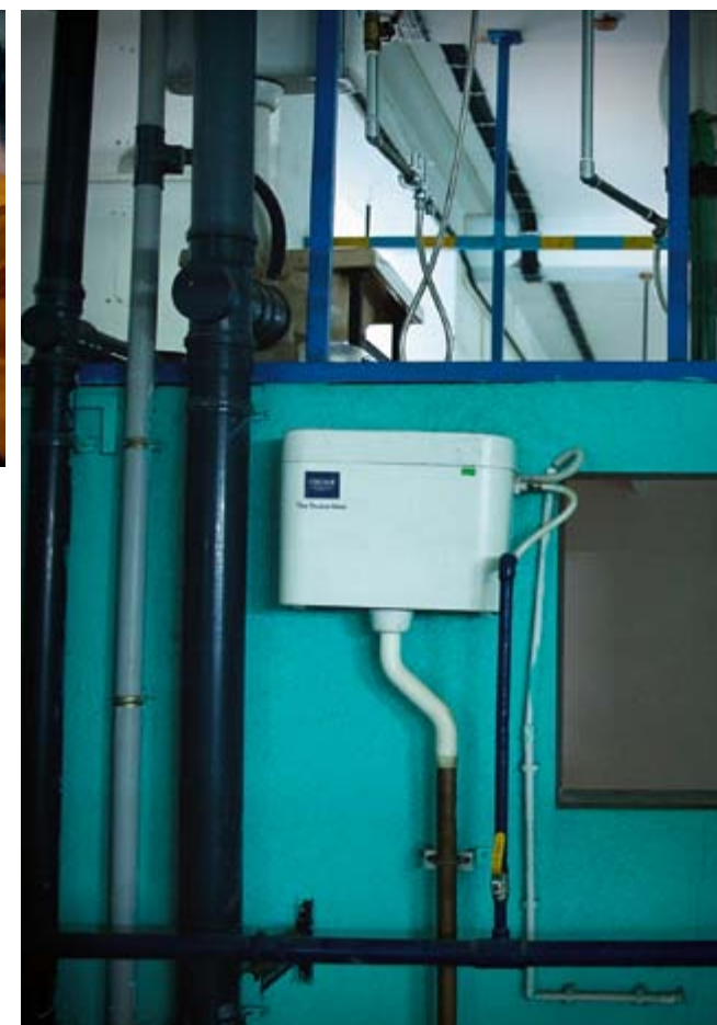
ВНИЗУ Студенты изучают работу пневматической системы слива
