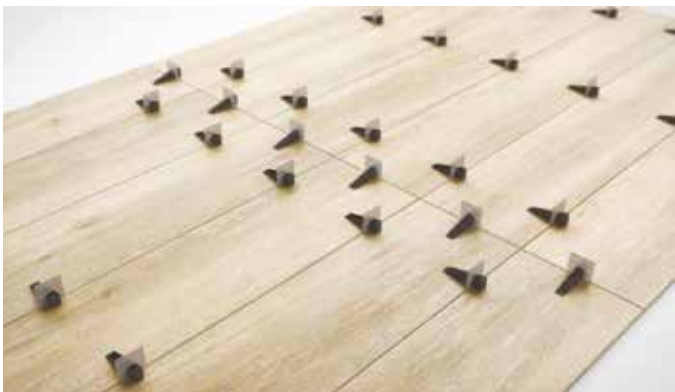
Sistema que mejora y facilita la colocación de cerámica. Easy System that improves the placement of tiles.
