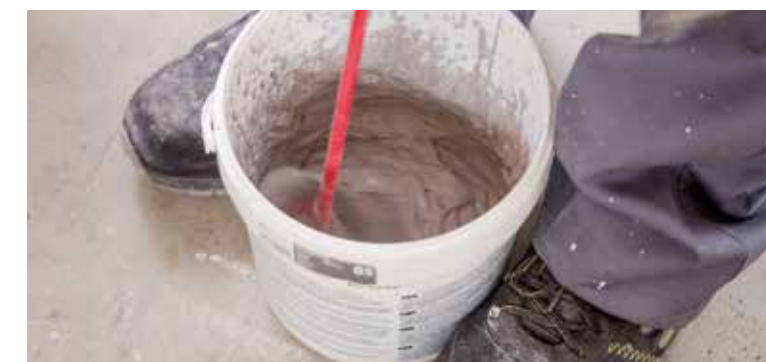
Prepare the grout | Prepara el material de rejuntado | Préparer le matériau de jointoiment | Rühren Sie das Fugenmaterial an
