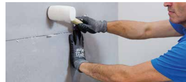
Use the flexible rubber mallet | Utiliza una maza de goma flexible | Utiliser un maillet en caoutchouc souple | Verwenden Sie einen biegsamen Gummihammer
