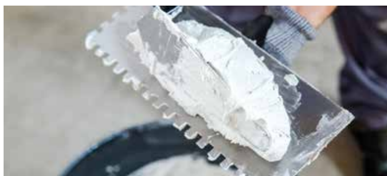
Spread the adhesive cement with a toothed trowel | Extiende el cemento de agarre con una llana dentada | Étendre le ciment à prise rapide à l'aide d'une spatule dentée | Verstreichen Sie den Klebemörtel mit einem Zahnpachtel
