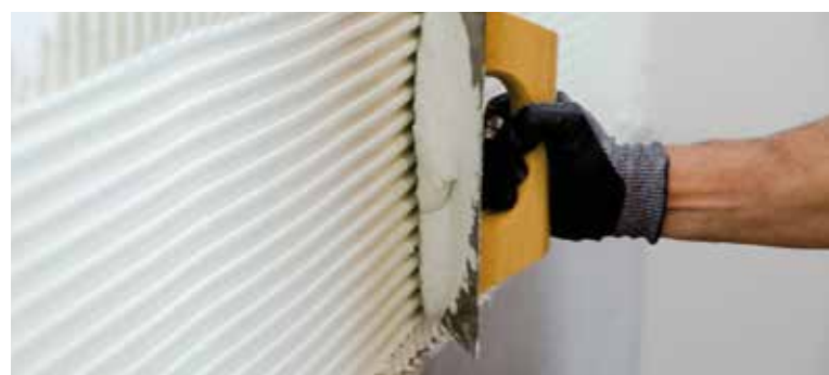
Make sure the thickness of the layer of adhesive cement is uniform | Asegúrate de que el grosor de la capa de cola sea uniforme | Veiller à ce que l'épaisseur de la couche de ciment colle soit uniforme | Vergewissern Sie sich, dass die Kleberschicht gleichmäßig ist
