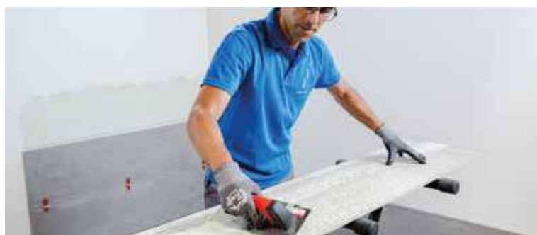
Spread the adhesive cement with a toothed trowel on the tile | Extiende el cemento de agarre con una llana dentada sobre la pieza | Étendre le ciment à prise rapide à l'aide d'une spatule dentée sur la pièce | Verstreichen Sie den Klebemörtel mit einem Zahnpachtel auf der Fliese
