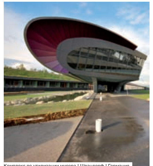
Комплекс по утилизации мусора | Швандорф | Германия
