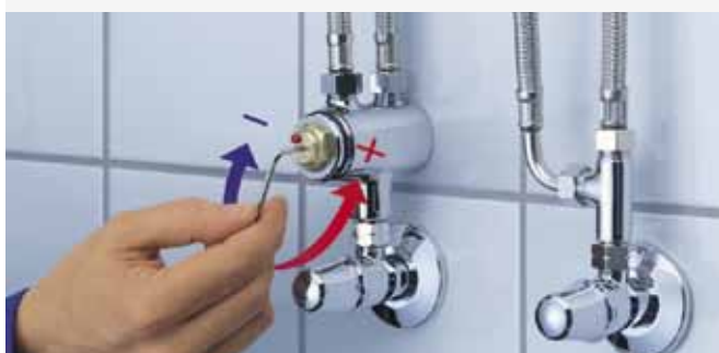
1 Настройка температуры с помощью шестигранного ключа
