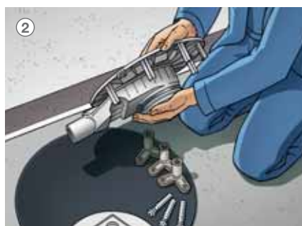
2 Подогнать регулируемое по высоте основание Advantix Top к строительным условиям.
