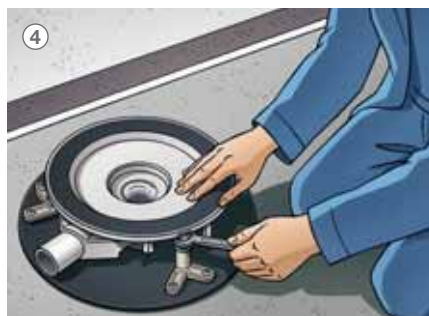
4 Установить трап и звукоизоляционный мат в нужное положение, выровнять трап с точностью до миллиметра при помощи регулируемых по высоте опор.
